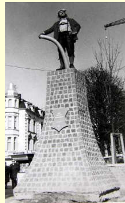
„Elefantenfüße“ für Pavillon 1976 wieder entfernt (Foto ?)
